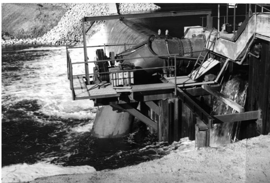
Rys.9 Turbozespół z turbiną lewarową TSP1000 w MEW Jaracz k/Rogoźna (woj. poznańskie): spad H = 2,4 m, moc elektryczna P = 47 kW
