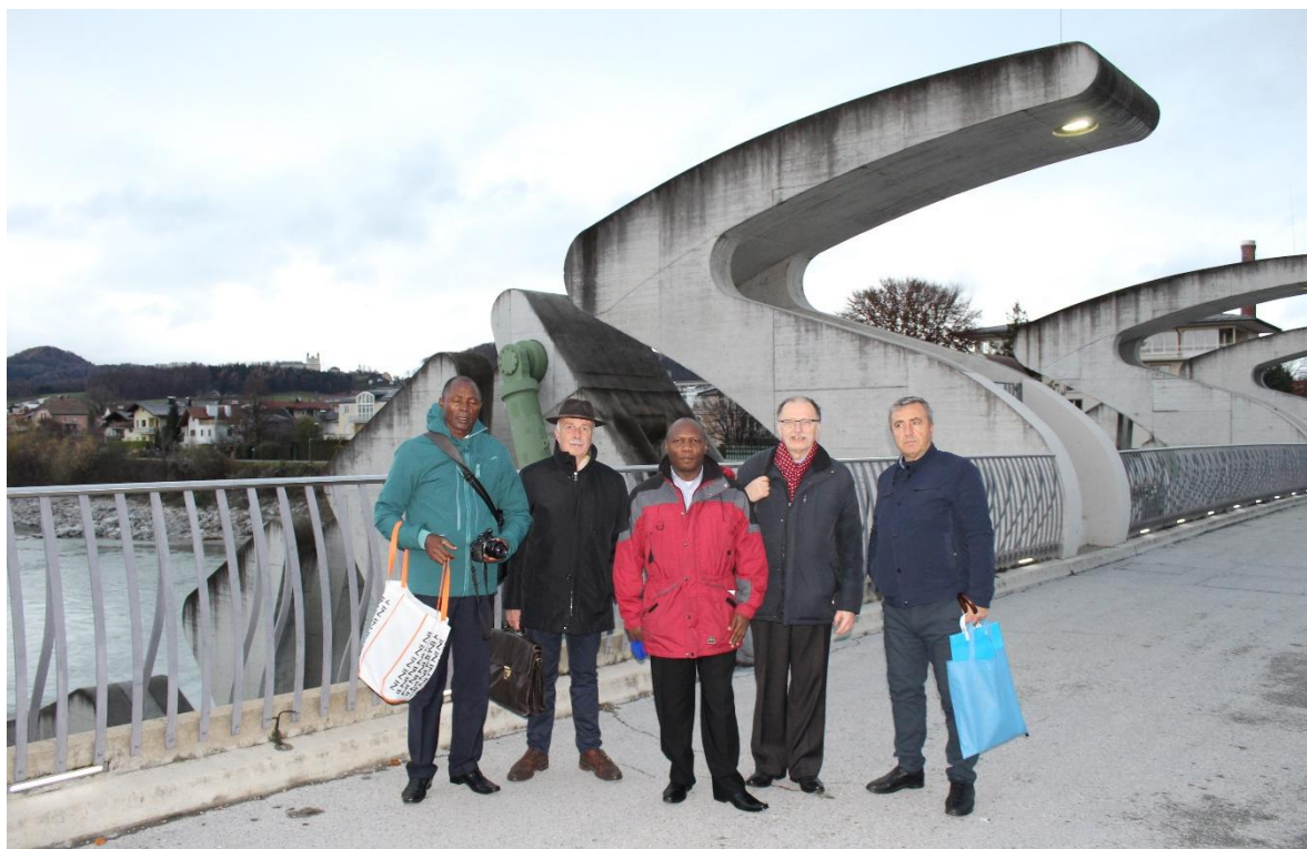
Na koronie jazu EW Lehen.
