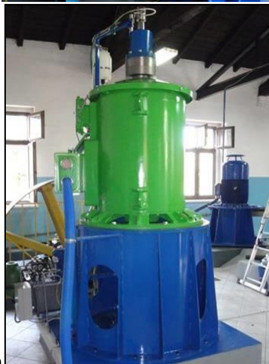
Rys. 3. Elektrownia wodna o mocy 160 kW z: a) prądnicą z silnika indukcyjnego z przekładnią pasową; b) bezprzekładniową prądnicą z magnesami trwałymi (źródło: KOMEL).
