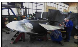
Rys.6 EW Tryszczyn-montaż nowego wirnika (materiał ZRE Gdańsk)
