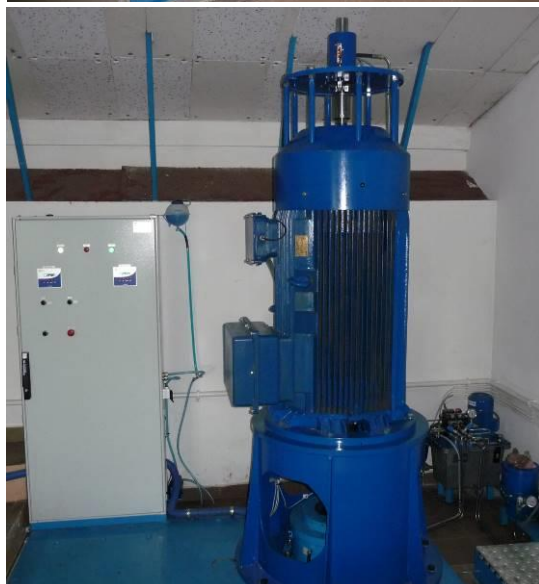
Rys. 2. Elektrownia wodna o mocy 75kW z: a) prądnicą z silnika indukcyjnego z przekładnią pasową; b) bezprzekładniową prądnicą z magnesami trwałymi (źródło: KOMEL).
