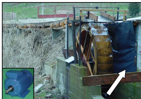
Rys. 1. Mała przydomowa elektrownia wodna w wykonaniu amatorskim o mocy 1,5 kW, strzałką pokazano miejsce zainstalowania prądnicy (źródło: własne autorów).
