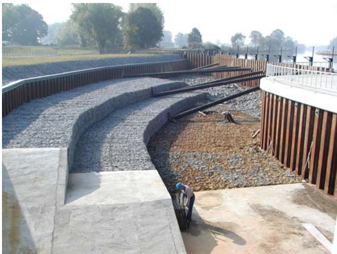
Rys.9 Profilowanie kanału doprowadzającego elektrowni wodnej w obejściu stopnia wodnego Januszkowice na Odrze
