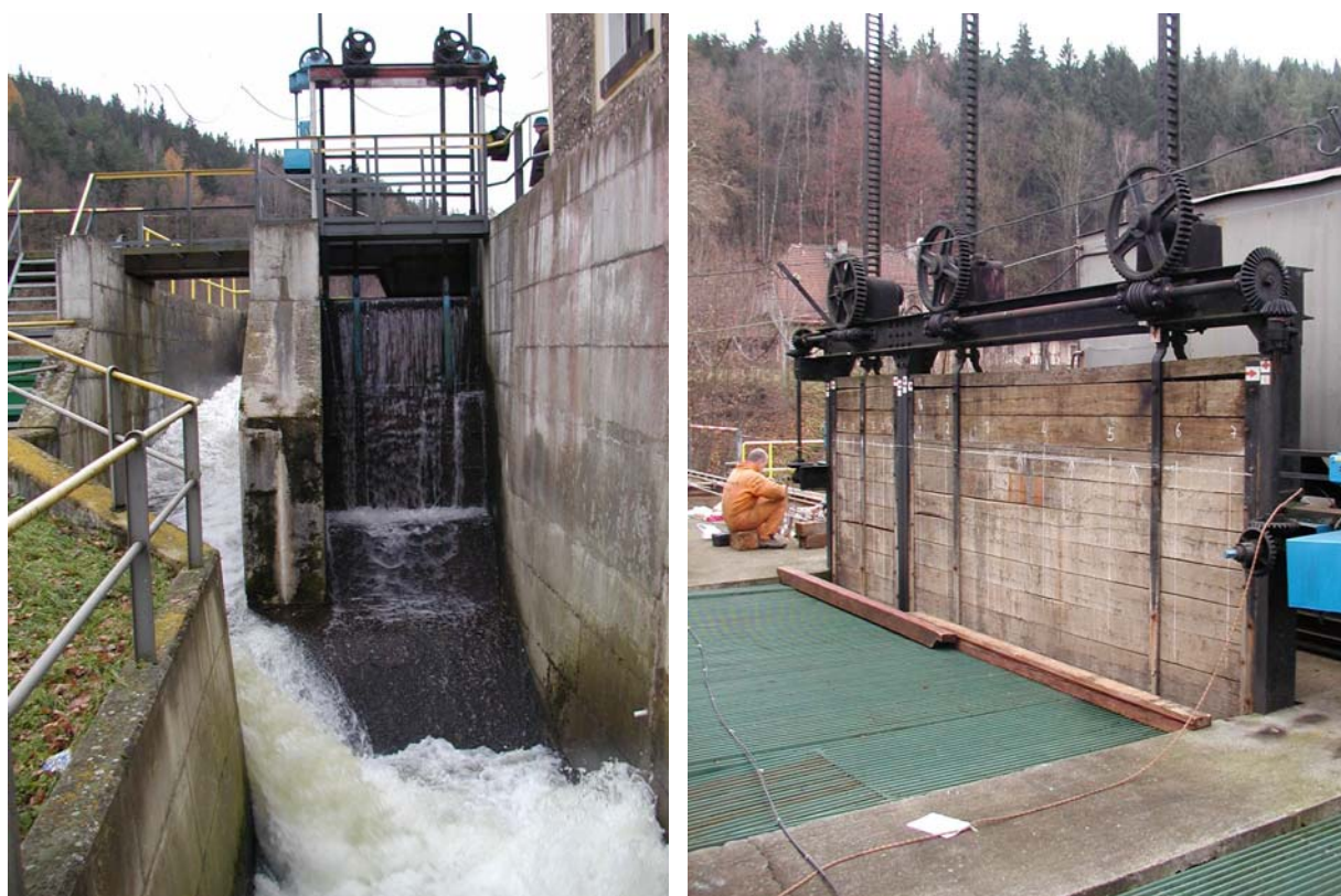
Rys.14 Zastawki na wlocie upustu regulowanego oraz na ujęciu wody hydrozespołu w EW Pilchowice II (moc: 824 kW, spad: 5,0 m). Zdjęcie po lewej wykonano przy wysokim poziomie piętrzenia – widoczny jest wypływ wody z przelewu nieregulowanego oraz nad zastawką upustu regulowanego.
