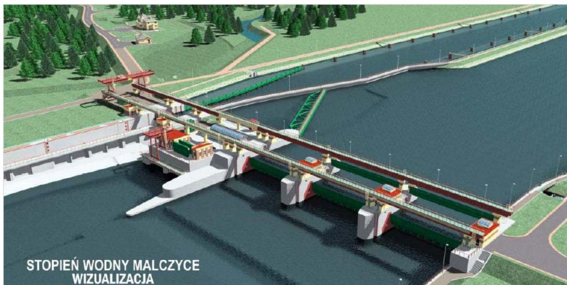
Rys.4 Przykład elektrowni wodnej przepływowej – elektrownia przy stopniu wodnym Malczyce na Odrze [3]
