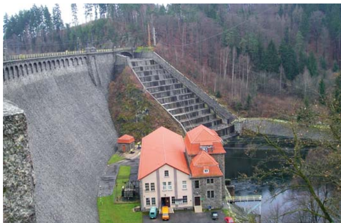
Rys.6 Elektrownia przyzaporowa Pilchowice I na Bobrze (moc: 7,6 MW; spad: 35 m)
