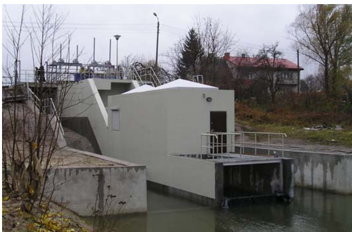
Rys.10 Mała elektrownia wodna zbudowana w świetle jazu - Elektrownia Wodna Pruszcz II na Raduni
